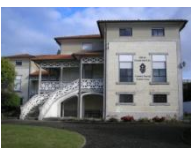
Centro Social Santa Cruz (Centro de acolhimento temporário)
